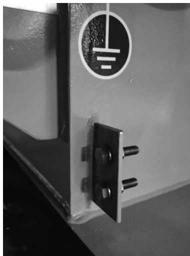
Figura 10.4 Conector de puesta a tierra (Con autorización de ABB Ltda., Dosquebradas, Colombia)
