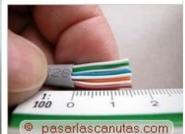
... hago otra comprobación por arriba: todos los cables llegan hasta el final, las cuchillas hacen conexión perfecta, atravesando el aislante.
