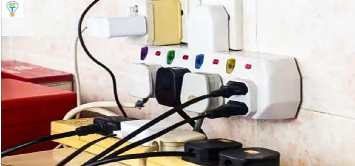
Si se conectan muchos equipos a un mismo tomacorriente, en el cable tanto de la parte interna donde se hace el contacto y el cable interno de la pared, no se puede notar que este recalentándose porque esta interno, eso va a ocasionar una fuga de energía de forma de recalentamiento. Esto se puede evitar, lo que se debe hacer es distribuir los equipos en varios tomacorrientes de la casa para que el cable no caliente.
