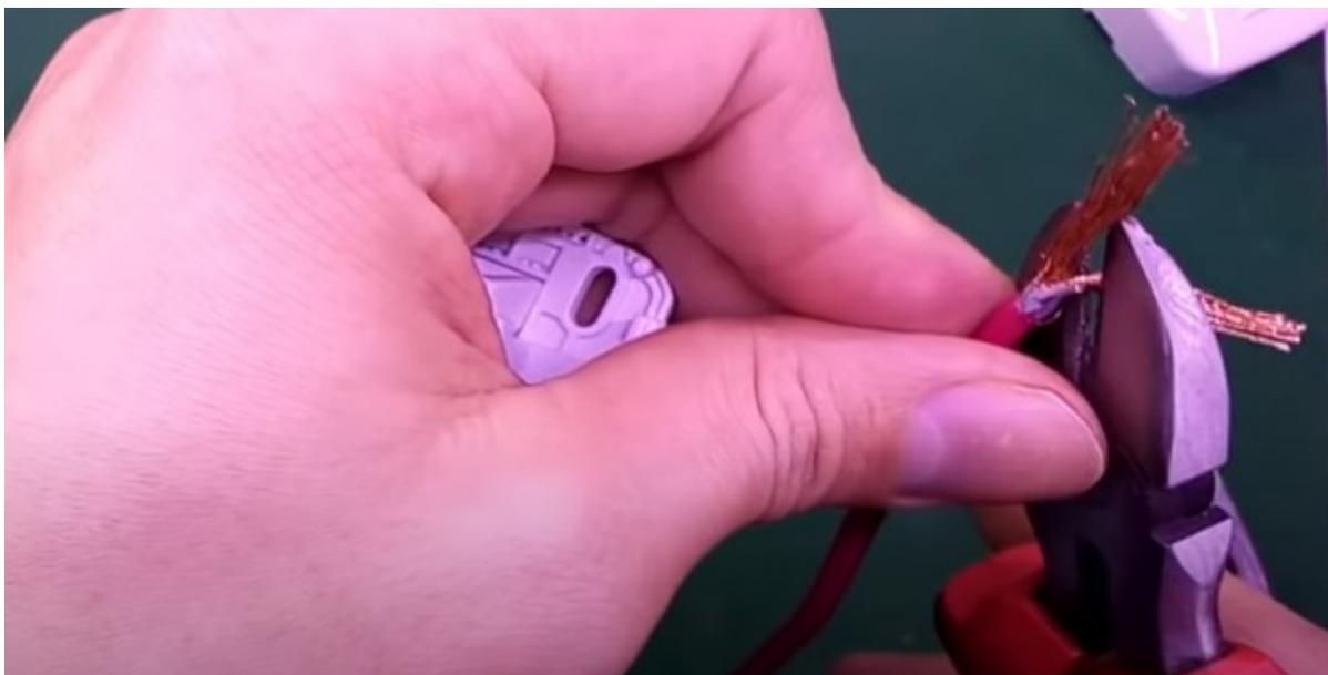
Lo que se debe hacer es enroscarlo en forma de cola de ratón, se puede dividir en dos partes de la misma proporción y enroscarlo.
