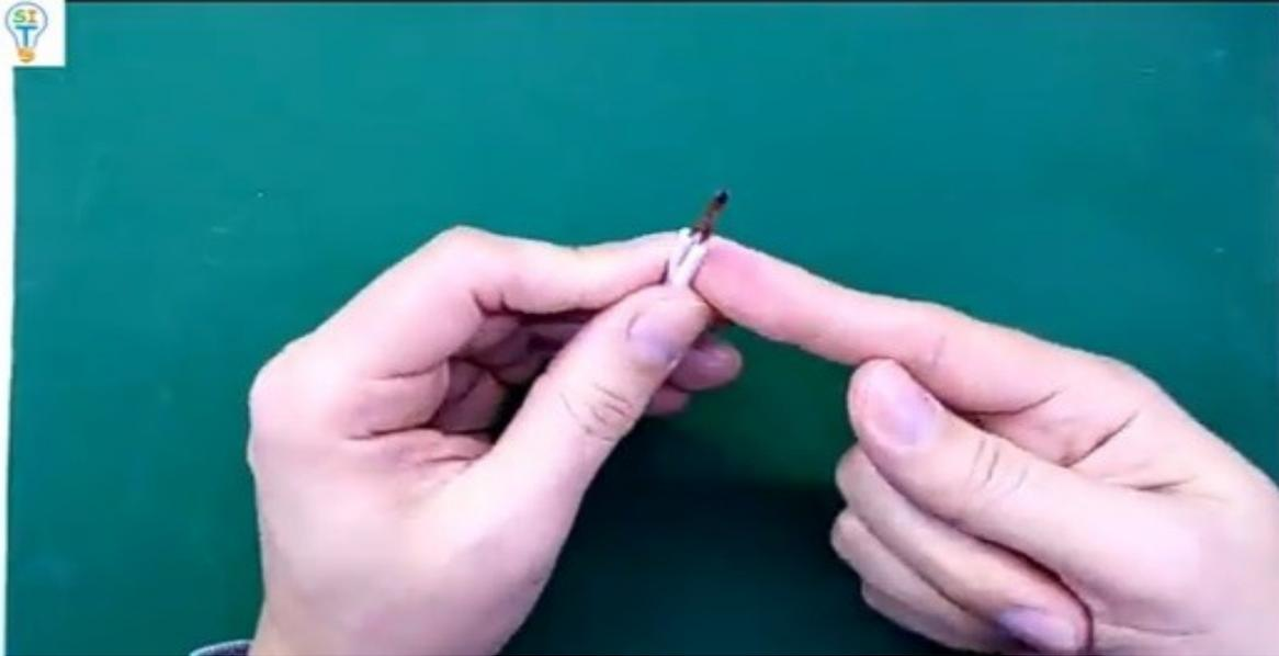
Lo que hacen es la unión de uno o más cables con el empalme de cola de ratón y se deja ahí empotrado, pensando que si el cable toca con la pared por ahí no va a conducir energía y resulta que si el cable toca con la pared si habrá una fuga de corriente.
